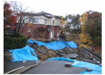
図 3-2. 人口崖の被害 （長岡市 T 団地）
