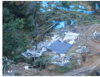
図 3-1. 自然崖の被害 （長岡市濁沢付近）
