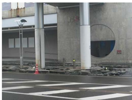
↑ 液状化により歩道の被害（上）再開発地域も被害大（下）
