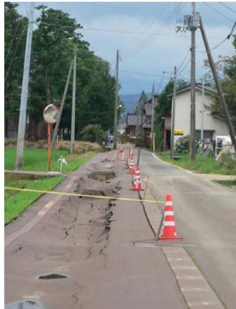
↑ 道路下配管部の陥没
