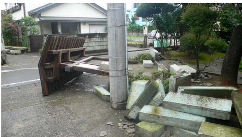
↑大家石の塀の被害。住宅の門が倒壊
