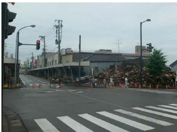
↑ 西側端。アーケードが傾き破損している
